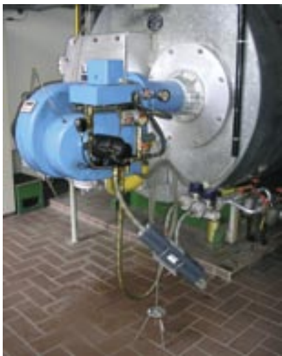
Der Ecojet wurde vor die Brenner auf die Zuleitung montiert
