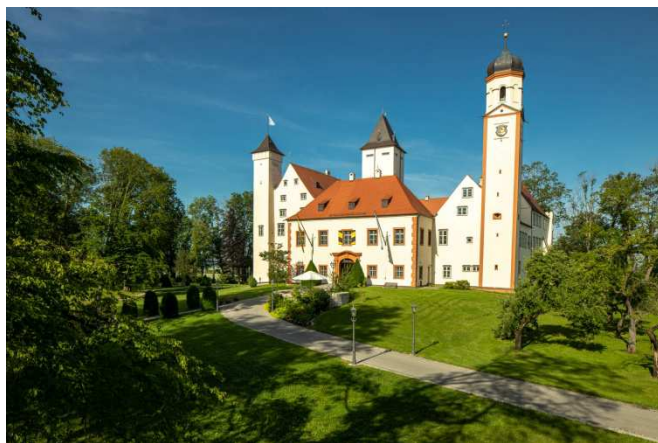
Schloss Hofhegenberg, ein weiteres vom EUROPEAN HERITAGE PROJECT saniertes Anwesen. Bildcredit: THE EUROPEAN HERITAGE PROJECT
