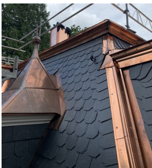
Schieferdach mit Kupfereinfassungen. Bildcredit: THE EUROPEAN HERITAGE PROJECT
