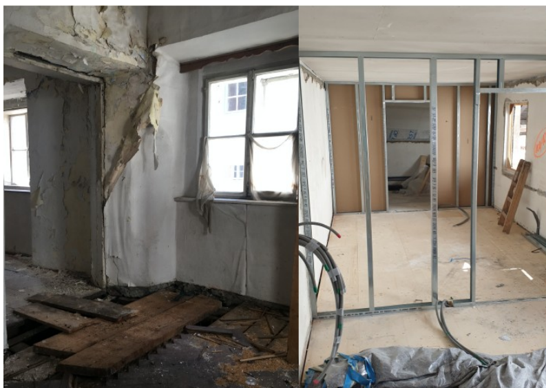
Innenraum des Lacknerhauses vor und während Sanierungsarbeiten.
