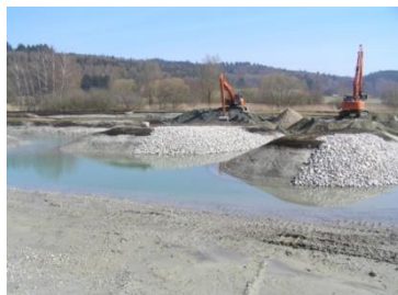
Die Bauphase: Bagger gestalten den Weiher und legen vielfältige Strukturen an. Foto: Markus Wolf
